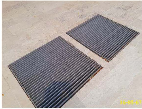
บ่อพักน้ำสุดท้ายก่อนระบายออกนอกโครงการ ภาพที่ 1.3.6-1 (ต่อ) การระบายน้ำและป้องกันน้ำท่วม
